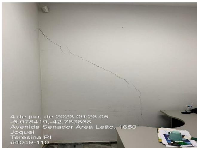
*Foto 35,36: Rachadura estrutural e ponto de infiltração pelo forro*
