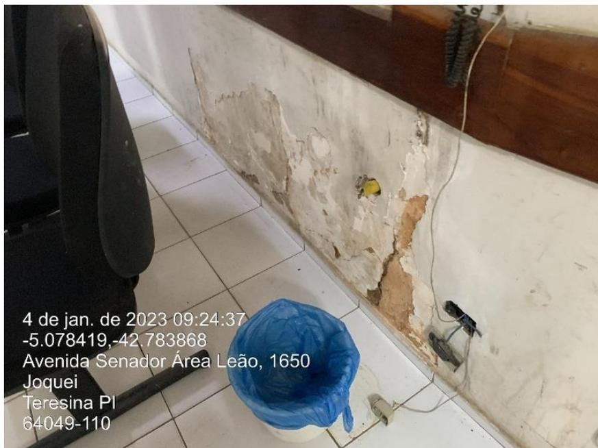
*Foto 37: Ponto de infiltração do solo*
