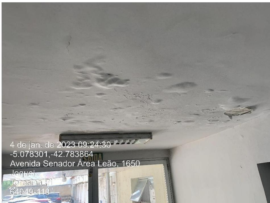
*Foto 34: Infiltração no forro*
