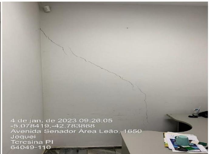
*Foto 40,41,42,43: Rachaduras estruturais parede e teto.*
