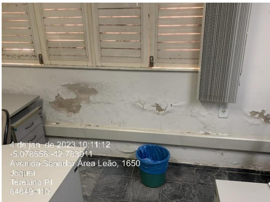
*Foto 28: parede com umidade, descascando a pintura*
