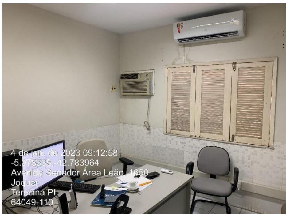
*Foto 29: Paredes com instalação de revestimentos cerâmicos para evitar a umidade e propagação de mofo, mesmo assim nota-se a mudança da cor da cerâmica por conta da umidade.*
