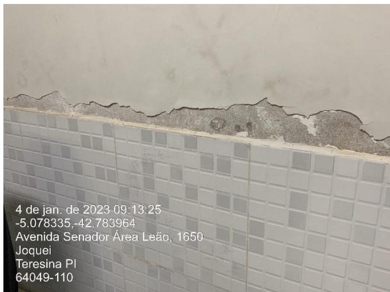
Foto 30: Parede descascando o reboco, por conta da umidade e do mofo.
