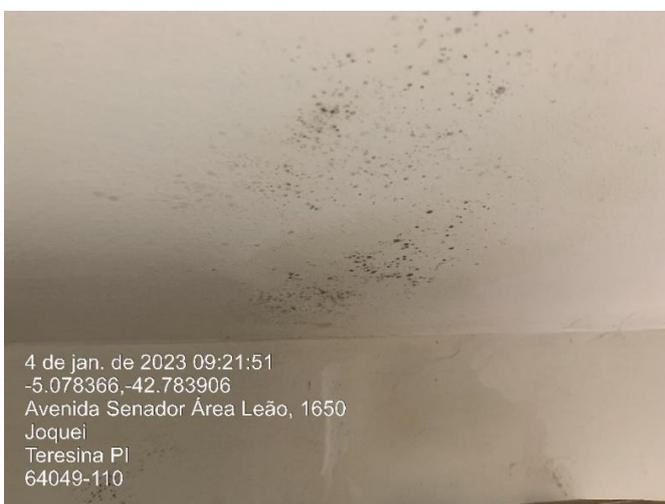
*Foto 38: Ponto de mofo na parede e no forro*
